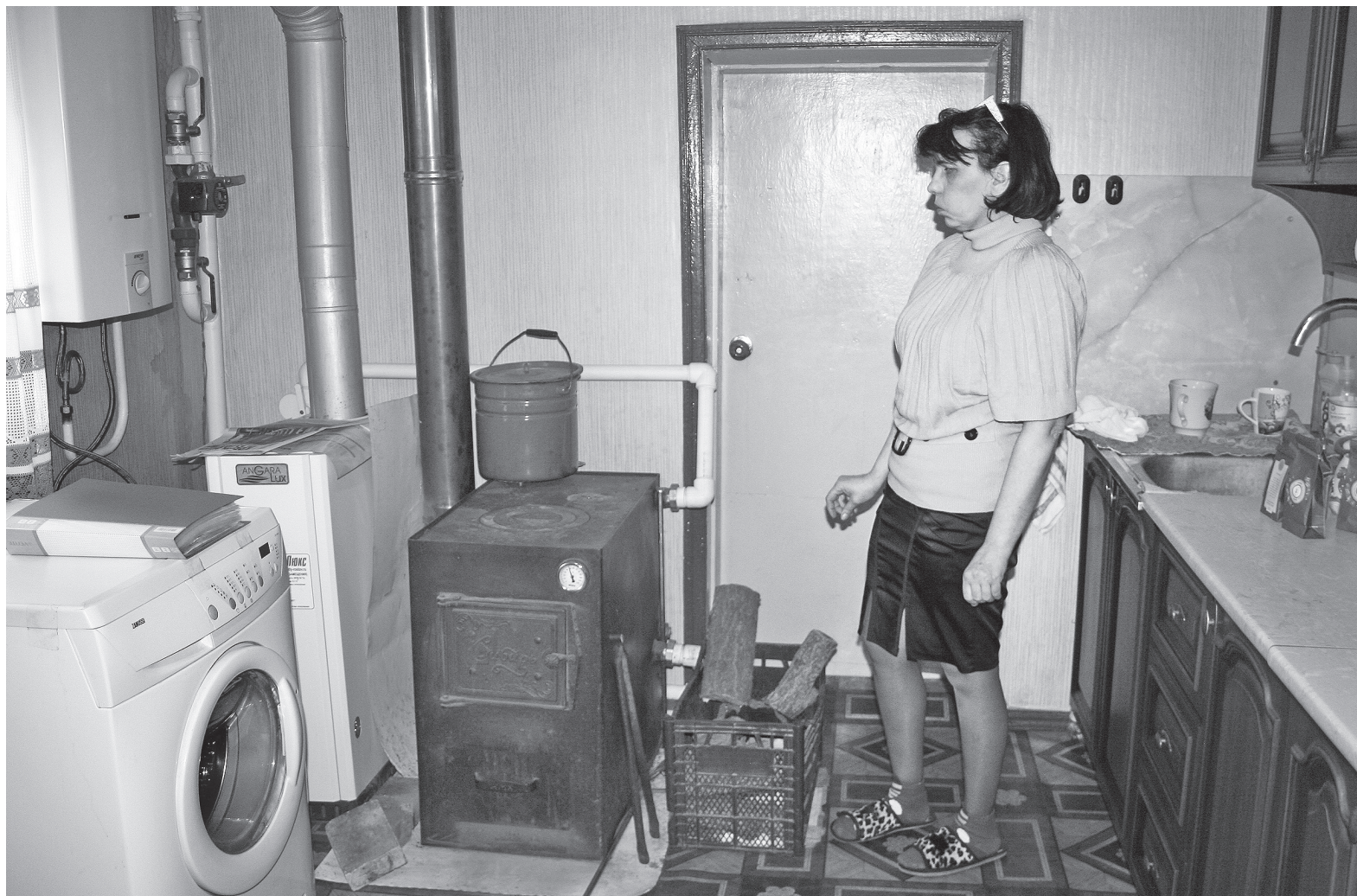
Теперь дом отапливает угольный котёл
