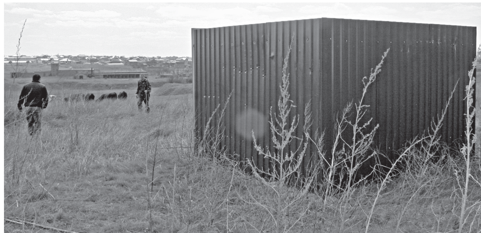
Забор установлен на площади 20 кв. м
