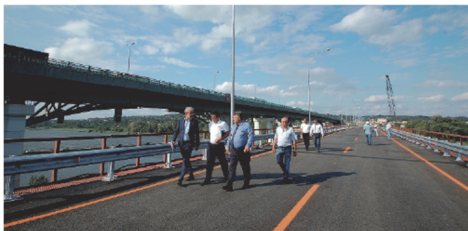
Открытие временного моста состоялось в намеченные сроки
