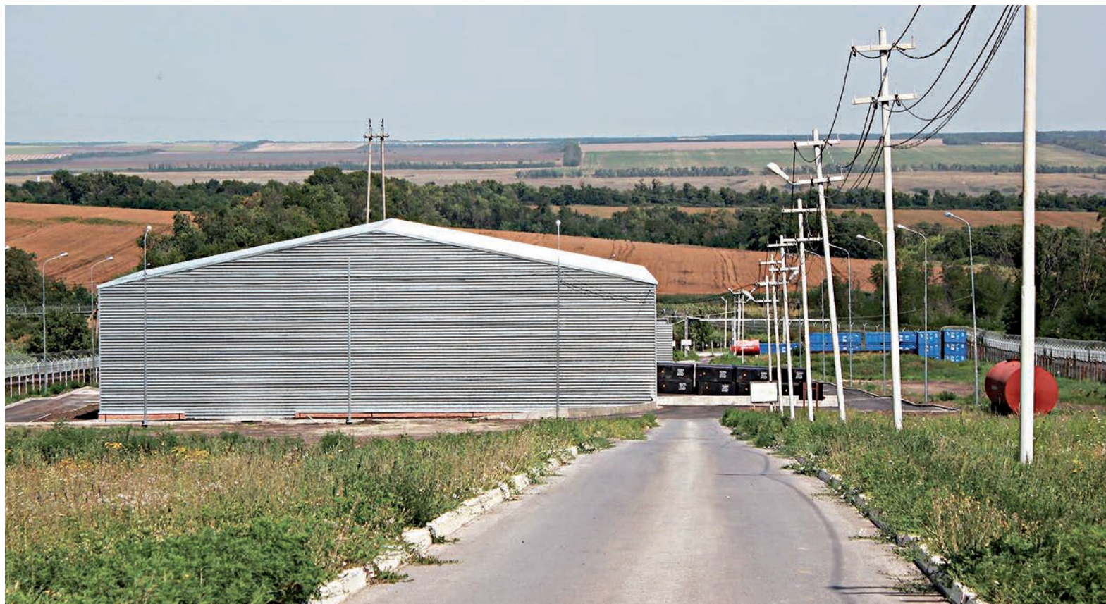
Новый ангар уже построен
