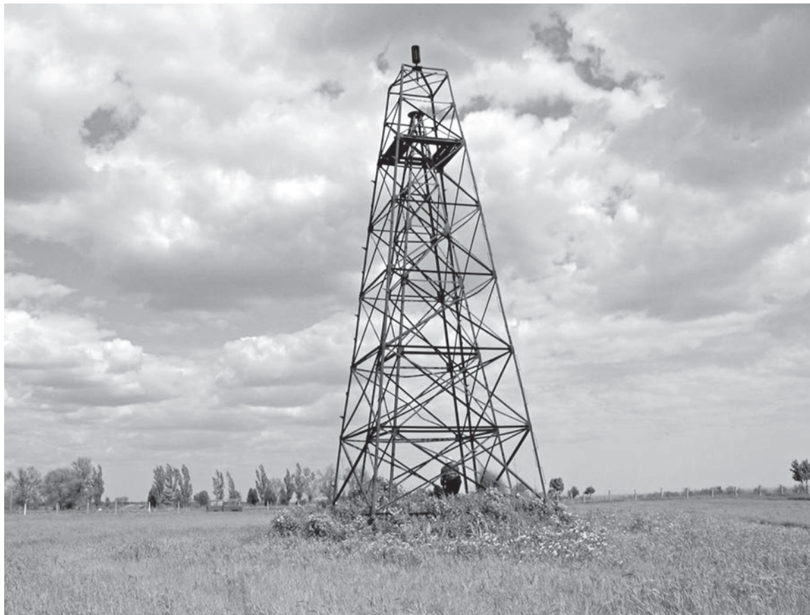
Межевые вышки в узловых точках опорных сетей срезали охотники за металлоломом, и началась «кадастровая чума»
