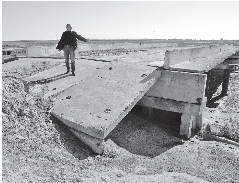
Когда-то дорога шла через этот мост
