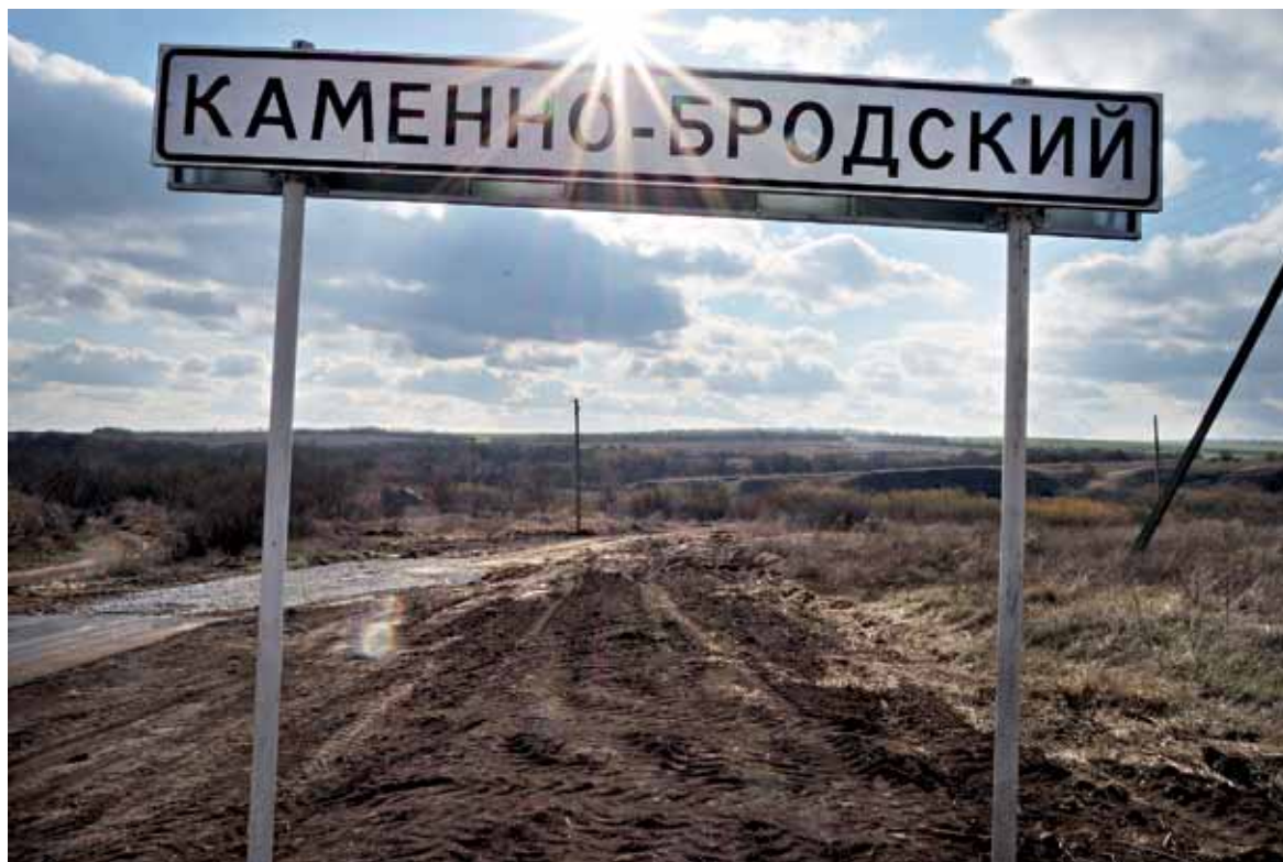
Дорога, на строительство которой потрачено 13,8 млн рублей, заканчивается сразу за указателем населённого пункта. По хутору дороги нет
