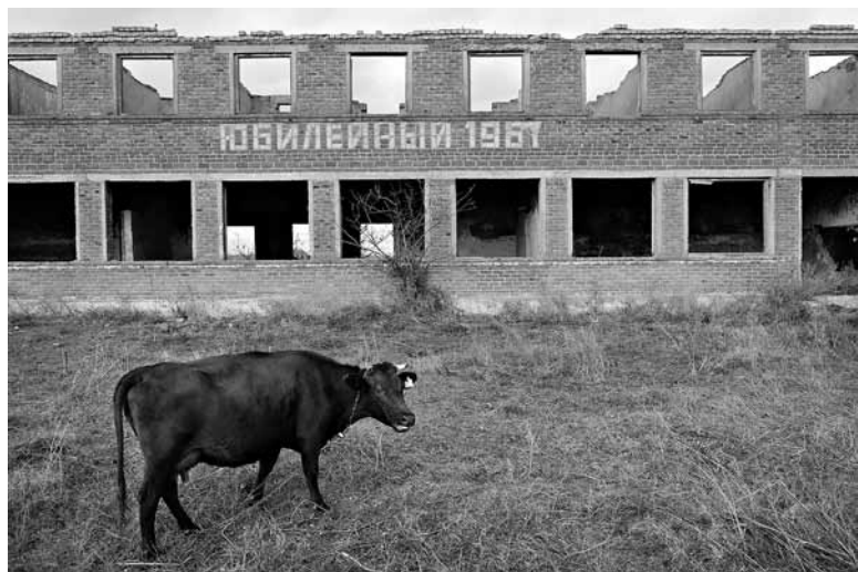
Полуразрушенное здание бывшего интерната СПК хотел отдать в ведение района под детский садик, но его восстановление и содержание администрация посчитала нерентабельным
