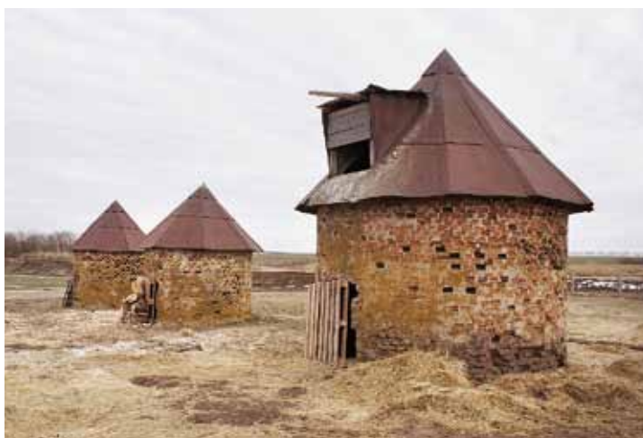
На силосных башнях новая только крыша
