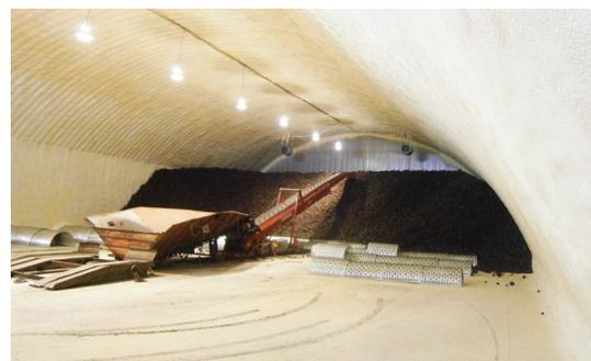
полиуретана на стены обеспечивает его полную теплоизоляцию. Построенное на совесть, бескаркасное овощехранилище прослужит хозяйству тридцать лет.
