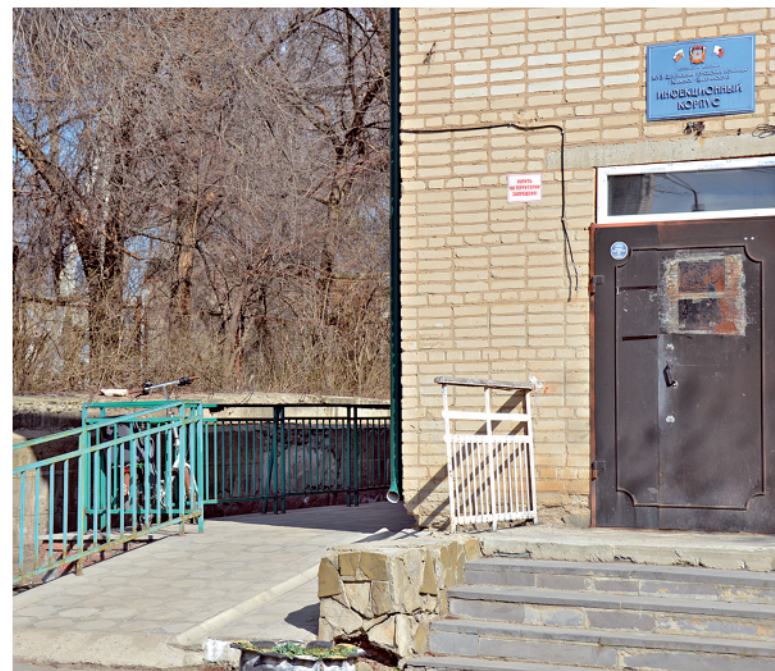
Инфекционный корпус Каменск-Шахтинской ЦГБ
