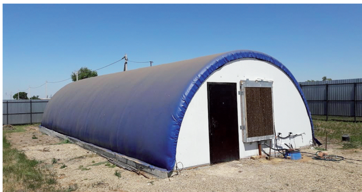
Ангар с теплоизоляцией, светом, вентиляцией
