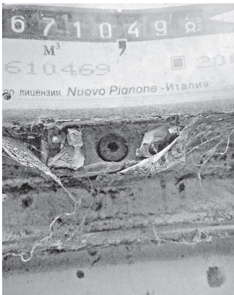
Сорванная пломба на счётчике
